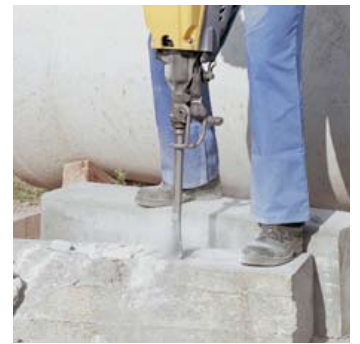
Briser le béton
